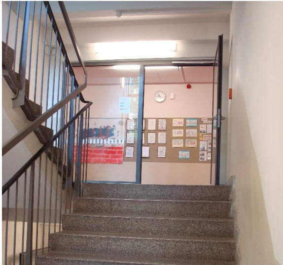
Blick in das Treppenhaus Nord
